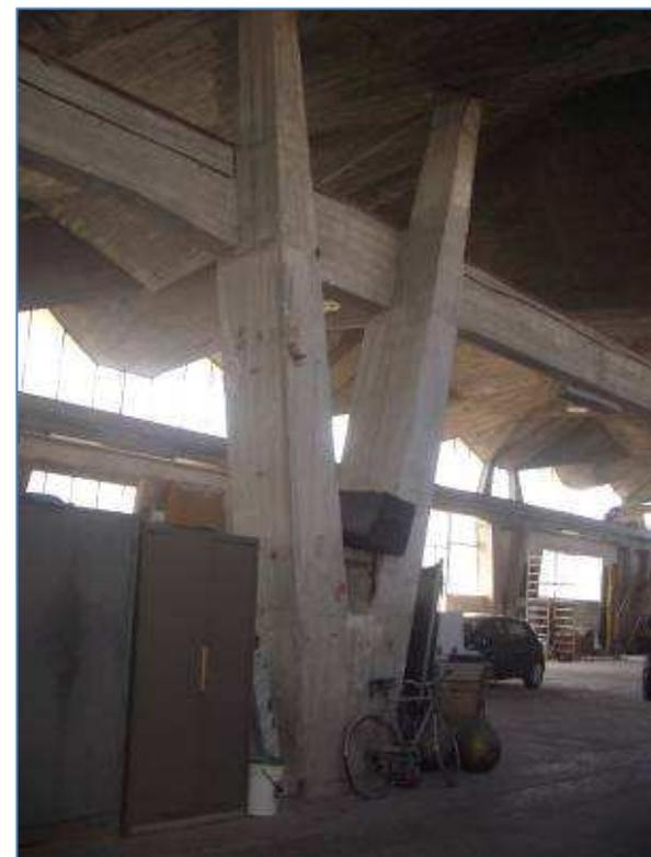
essere costruita con sufficiente rapidità e soprattutto con una spesa ridotta. Si è progettata una copertura in soletta sottile gettata in opera su cassaforme in legname e destinata a restare completamente in vista. La prima idea che si è seguita per avvicinarsi alla forma definitiva della struttura è stata che se il corrugamento della
